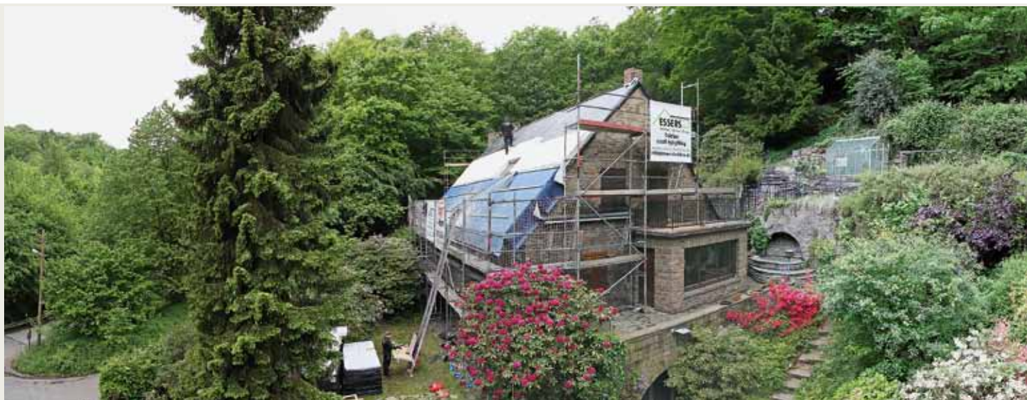
Panoramabild: Baustelle in einem romantischen Tal in Essen
